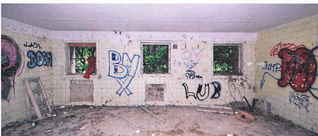
A déli homlokzat mögötti helyiségek belső terei alagsor – földszint – emelet
