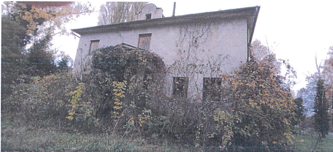
1. Épület nyugati homlokzata
