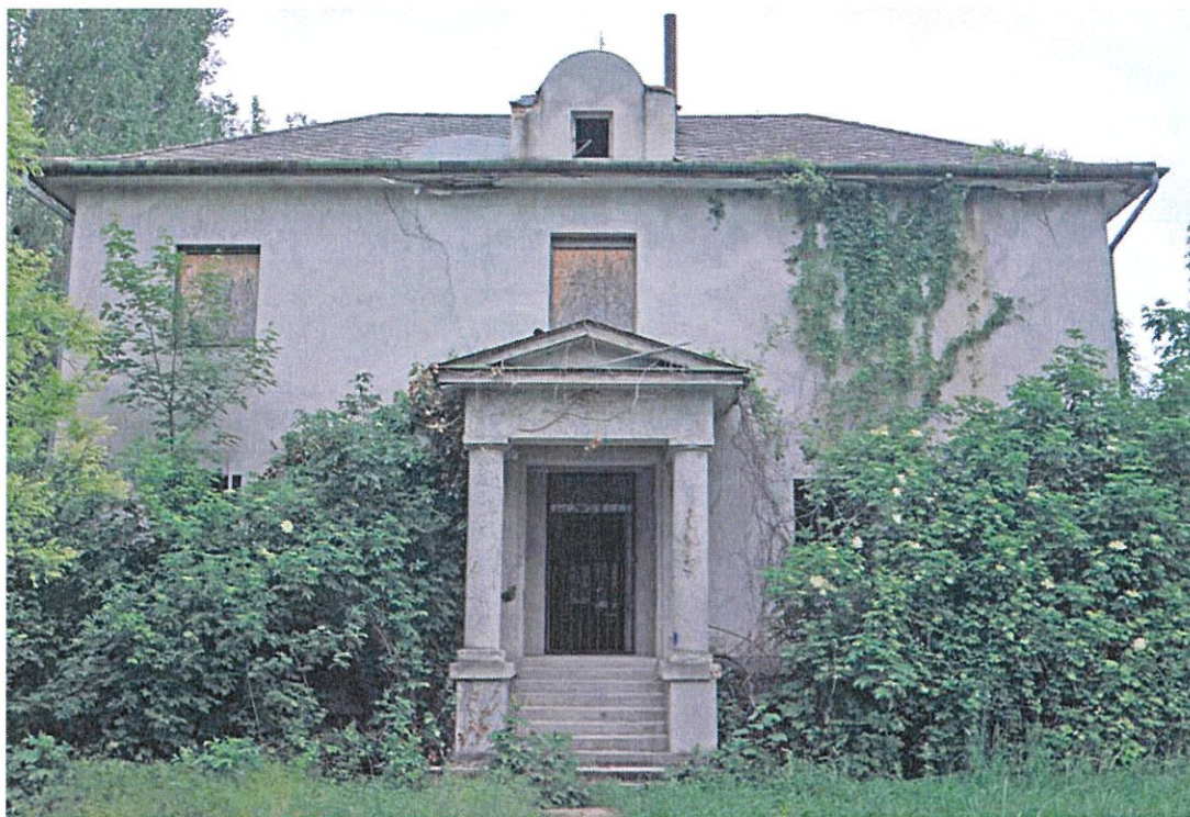
Főbejárati – északi – homlokzat
