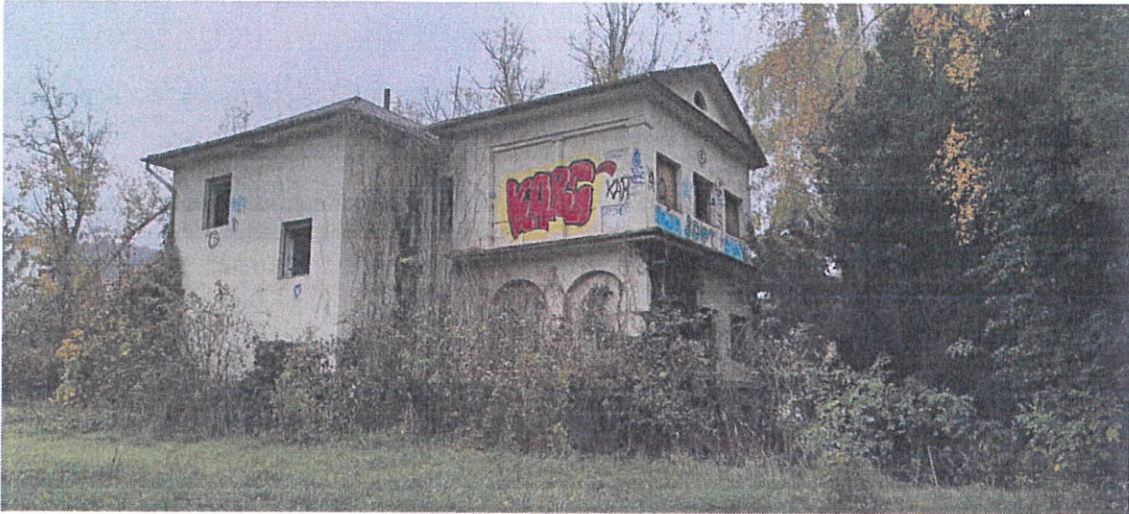
1. Épület déli homlokzata
